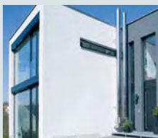
Einfamilienhaus Wiesloch, Deutschland
