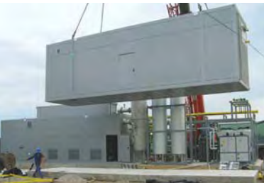
Einfaches Handling auf der Baustelle durch betriebsfertige Containerausführung
