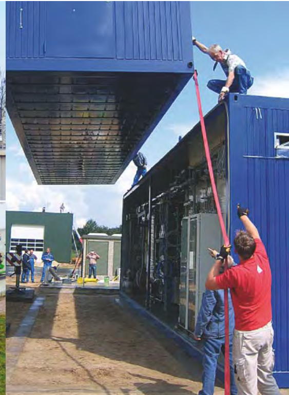
Anlieferung der Containermodule für die BGAA der EWE AG in Werlte
