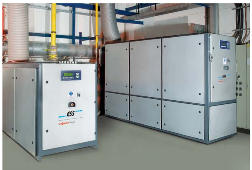
Vitobloc 200 ist serienmäßig mit Synchrongenerator und Startbatterien ausgestattet.
