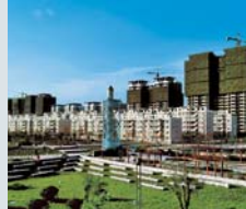
Wohnanlage „Zi Wei Garden“ Xi'an, China
