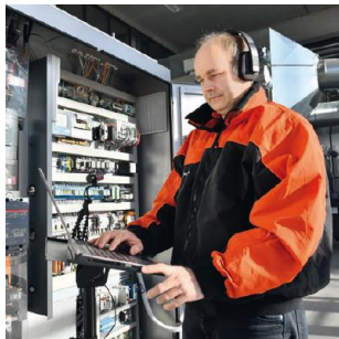
Bild 2: Mit dem AuVis-System von Viessmann wird der Techniker vor Ort via Liveschaltung in Bild und Ton unterstützt.
