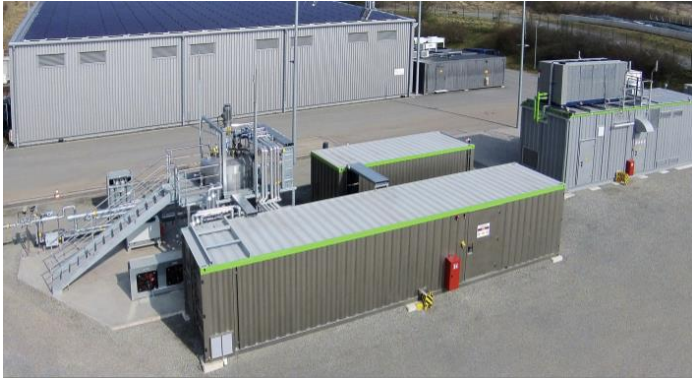
Bild 1: In Allendorf wird mittels biologischem Verfahren aus regenerativem Strom Methan erzeugt und ins öffentliche Erdgasnetz eingespeist.
