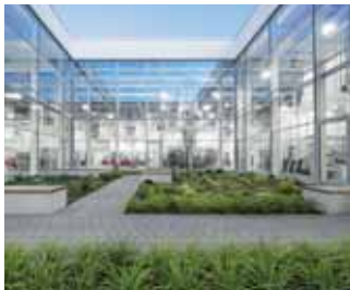
Außenansicht des neuen Technikums am Standort Allendorf
