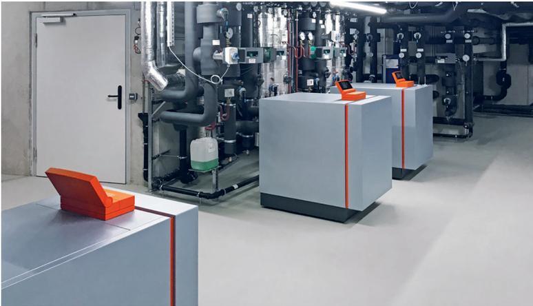
In der Heizzentrale sorgen Wärmepumpen, Biogaskessel und -BHKW, Pelletkessel und eine angeschlossene PV-Anlage für Heizung, Kühlung und Strom.
