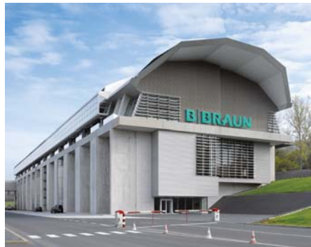
Produktionsgebäude B|Braun Melsungen AG Production facility at B|Braun Melsungen AG, Germany
