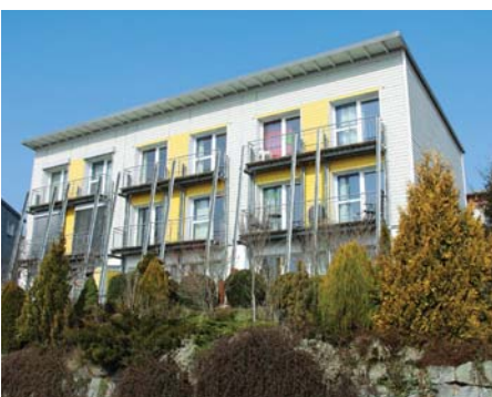
Passivhausiedlung „Im Sonnenfeld“, Ulm Passive housing estate „Im Sonnenfeld“, Ulm, Germany
