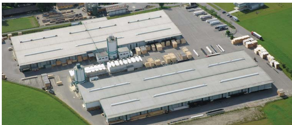
Mosser Leimholz, Perwarth, Österreich Mosser Leimholz, Perwarth, Austria
