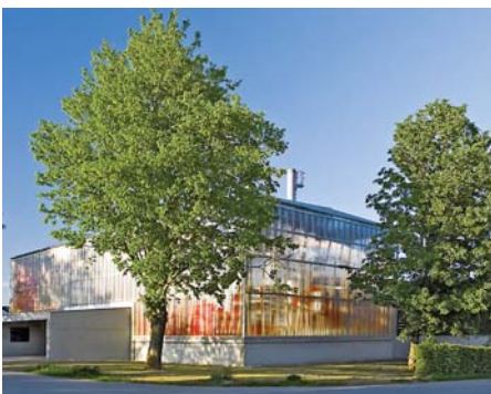
Heizzentrale Kloster St. Ottilien Heating centre at St. Ottilien Abbey
