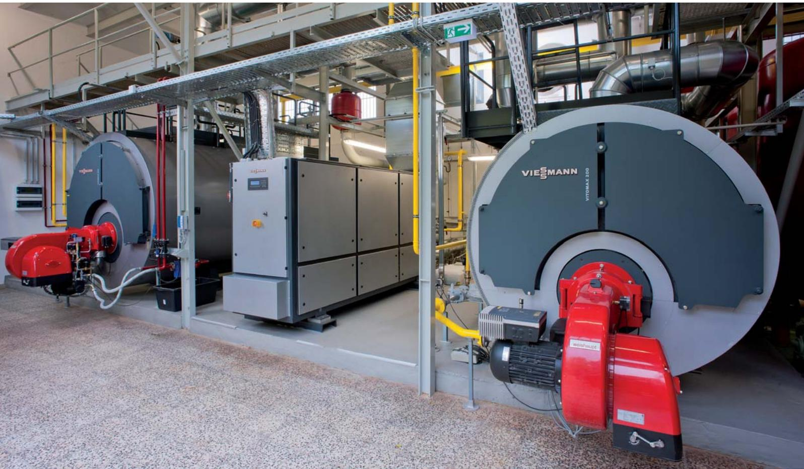
Die Vitomax 200-LW Heißwassererzeuger leisten 4,5 und 2,3 MW. Das Blockheizkraftwerk Vitobloc 200 hat 207 kW thermische und 140 kW elektrische Leistung.
