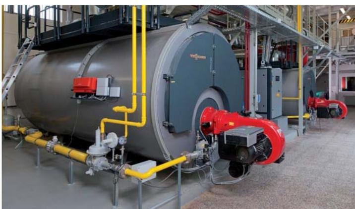
Die Vitomax Heißwasserkessel werden primär mit Erdgas versorgt – der Brenner des 4,5-kW-Kessels kann aber auch mit Öl betrieben werden.
