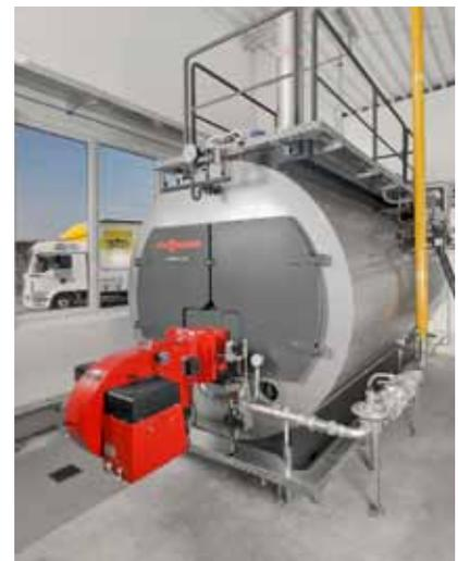
StoVerotec produziert mit neuer Industrie-Anlage Hochdruck Dampf - einem Vitomax 200 von Viessmann.
