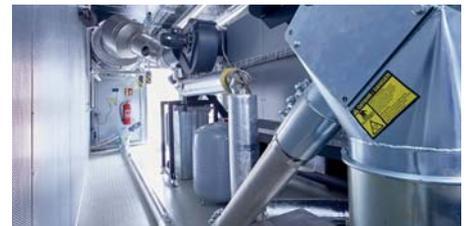
Zuführung der Pellets über Transportschnecken aus dem beigestellten Lagercontainer
