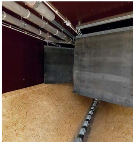
Blick in den Pelletcontainer mit einem Fassungsvermögen von 30 Tonnen
