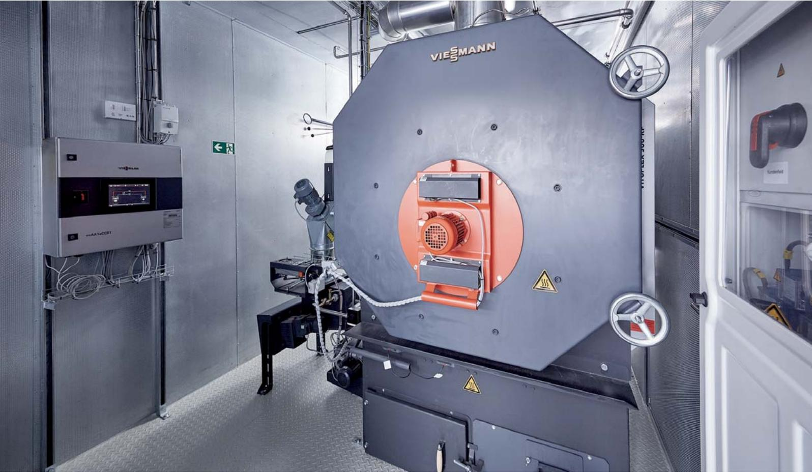
Der Vitoflex 300-RF Biomassekessel verfügt über eine Nenn-Wärmeleistung von 540 kW. Über Vitocontrol 200-M (I.) ist die umfassende Regelung und das Monitoring des Biomassekessels möglich.
