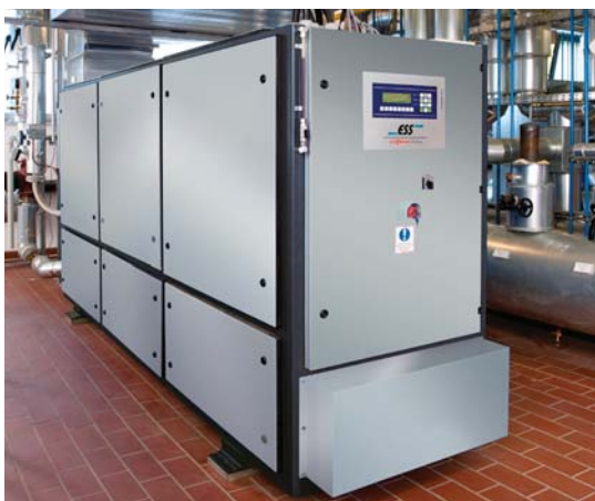
Das kompakte BHKW Vitobloc 200 ist schalldämmend auf Gummi- puffern gelagert.
