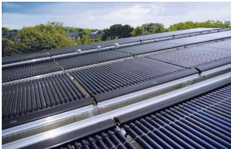
Die thermischen Solaranlagen Vitosol 200-T übernehmen ca. 60% der Warmwasserbereitung und werden zusätzlich zur Heizungsunterstützung eingesetzt.
