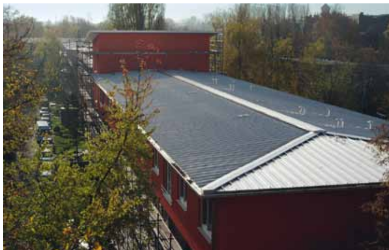
Die Aufstockungen an den Südgiebeln wurden jeweils mit einem Pultdach versehen, das vollflächig Solaranlagen aufnimmt.
