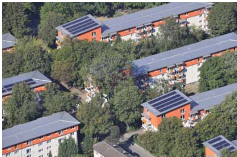
Die Gebäude stehen in Ost-West-Richtung – das brachte die optimale Voraussetzung für die vollflächigen Solaranlagen auf den Pultdächern an den Südgiebeln.
