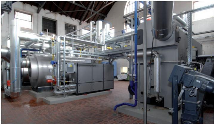
Pelletkessel und BHKW liefern ganzjährig rund 90 Prozent der benötigten Wärme. Die beiden Vitomax 300 Heizkessel decken Spitzenlasten ab und dienen als Redundanz im Servicefall.
