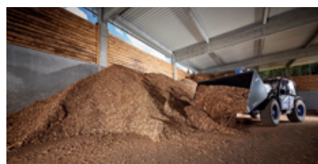
Die Halle für das Hackschnitzzellager hat ein Fassungsvermögen von 5000 m 3 .
