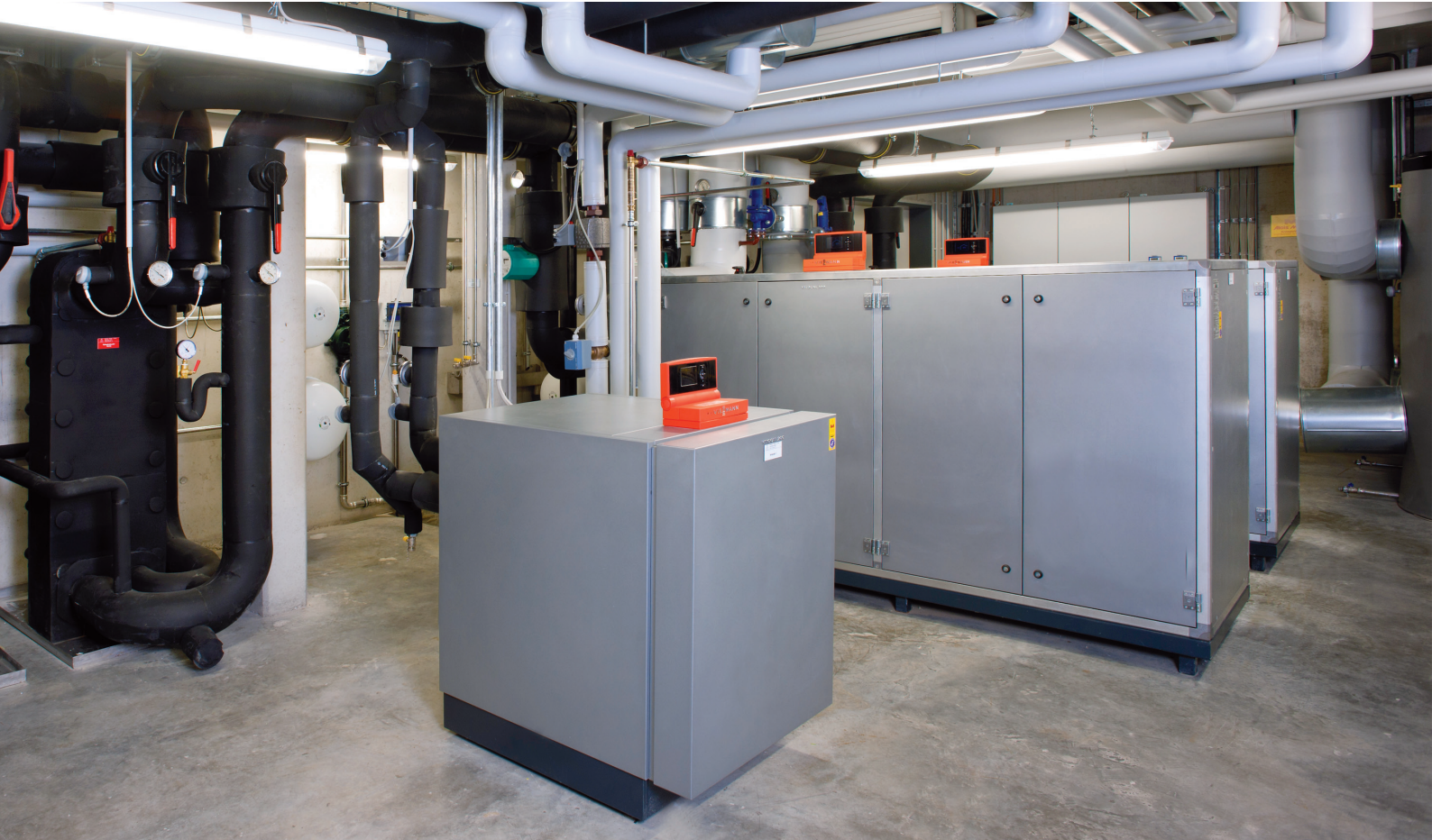
Wärmepumpen Vitocal 300-G Pro (rechts) und Vitocal 300-G (links)
