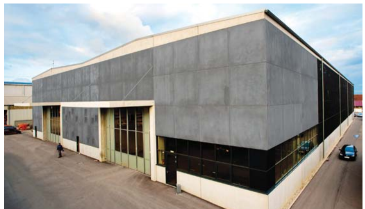
1400 Quadratmeter groß ist die Kollektorfläche aus anthrazit durchgefärbten Betonfertigteilen.
