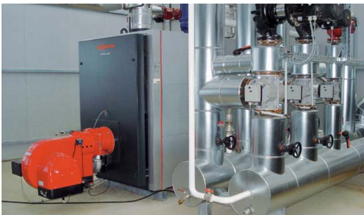
Vitoplex Gasheizkessel mit einer Leistung von 1950 kW
