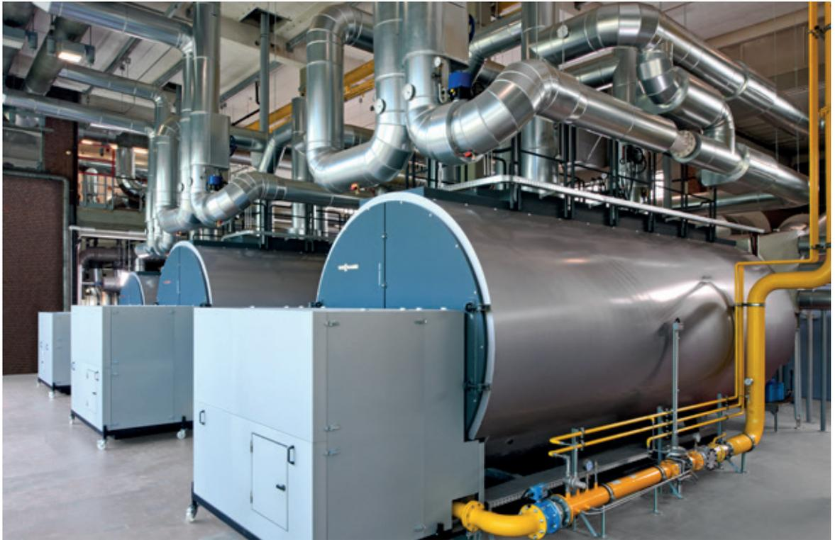
Die drei Niederdruck-Heißwassererzeuger Vitomax LW verfügen über eine Gesamtleistung von 32 MW.
