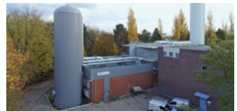
Der Heizwasser-Pufferspeicher (links) hat ein Fassungsvermögen von 200 m<sup>3</sup>.
