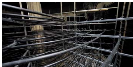
Innenansicht eines Eisspeichers während der Bauphase
