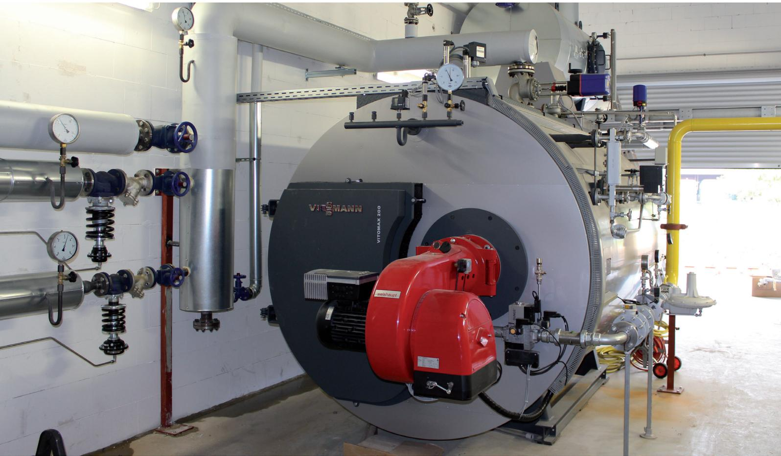
Bei einem Betriebsdruck von maximal 13 bar liefert der Hochdruck-Dampferzeuger Vitomax 200-HS bis zu 3,2 Tonnen Dampf pro Stunde.
