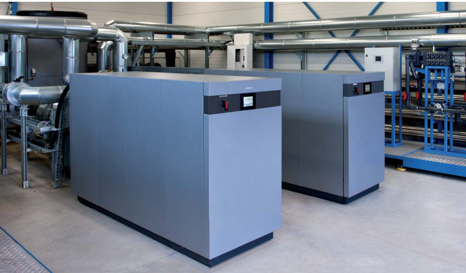
Wärmepumpen Vitocal 350-G Pro mit einer Gesamtleistung von 620 kW
