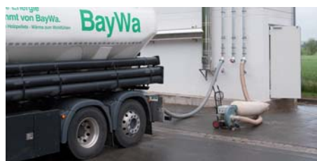
Befüllung des Lagercontainers mit Holzpellets – das Sauggebläse verhindert einen Überdruck im Lagerraum.
