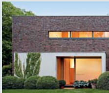
Einfamilienhaus Kevelaer, Deutschland
